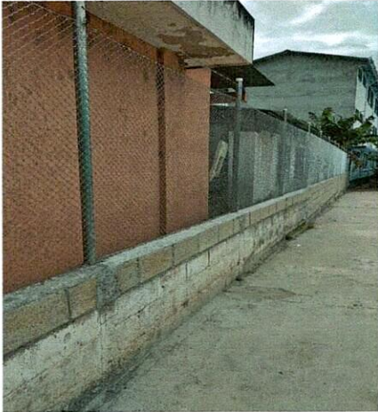
Foto1: REMOZAMIENTO MURO PERIMETRAL LADO SUR
