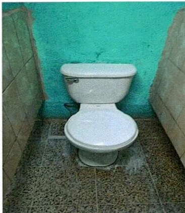
Foto 3: CAMBIO DE SANITARIOS
