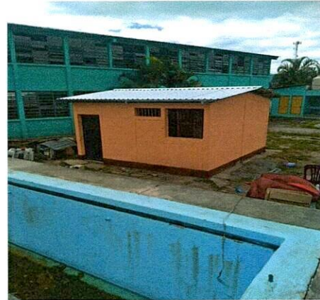
Foto 2: CAMBIO ESTRUCTURA Y LAMINA BODEGA
