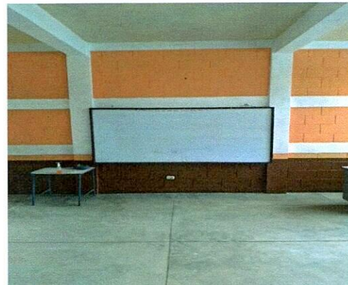
Foto 4: PINTURA DE AULAS
